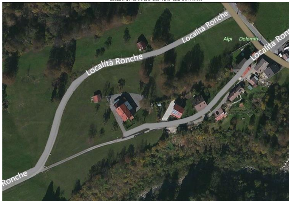
Fig.6 - Inquadramento fotogrammetrico dell'area interessata dall'intervento.
