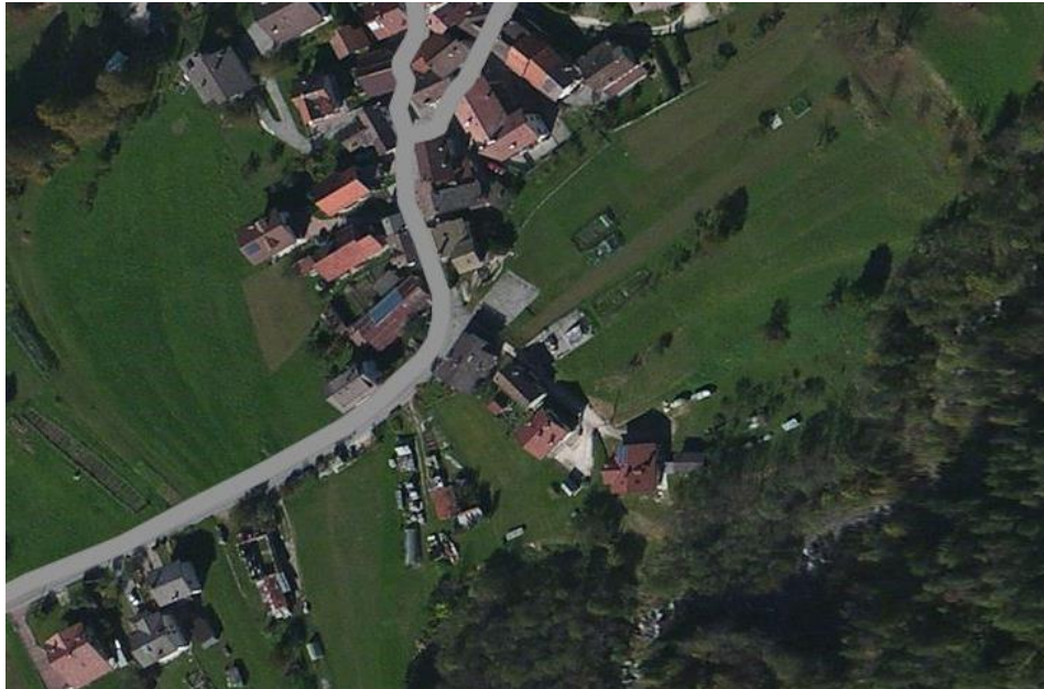
Fig.16 - Inquadramento fotogrammetrico dell'area interessata dall'intervento.
